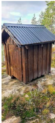
Bygning over bergborebrønn.
