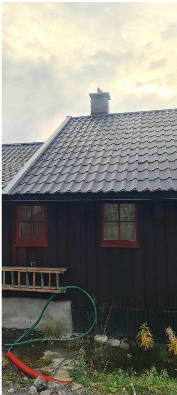
Elementpipe over tak hvor ny el.kabel er etablert fram til grunnmur.
