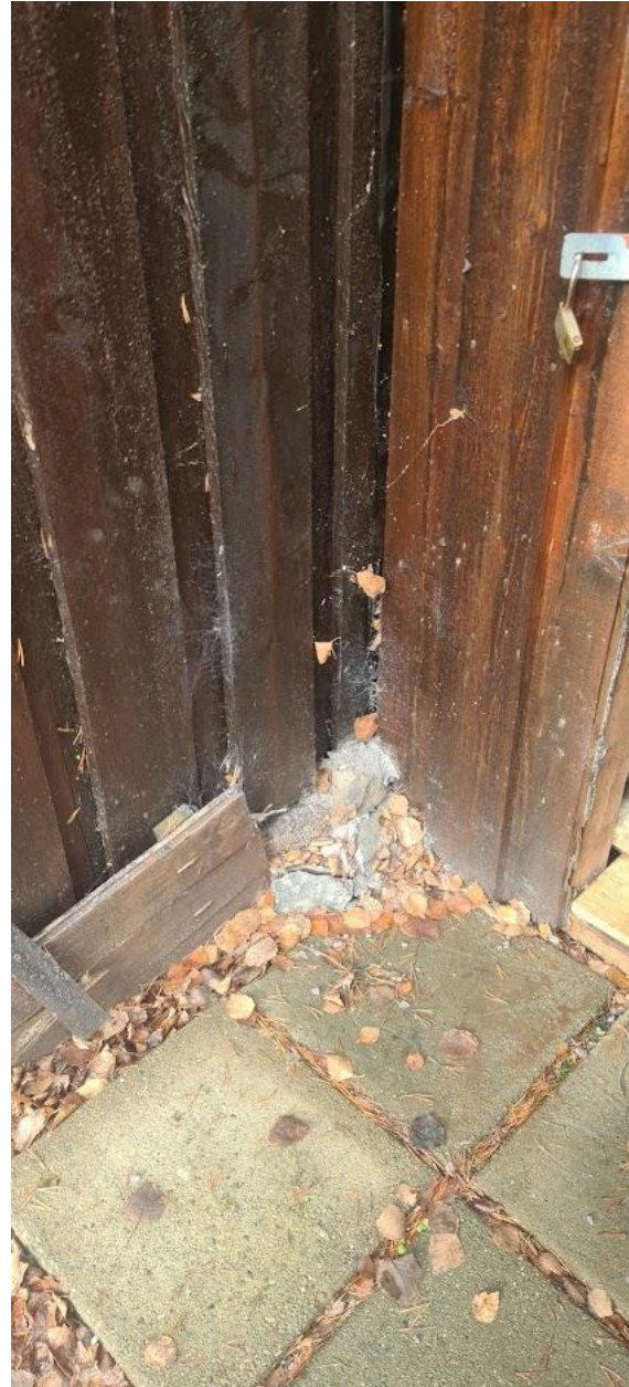
Innvendig hjørne agratrom/uthus hvor støpt pilar er synlig.
