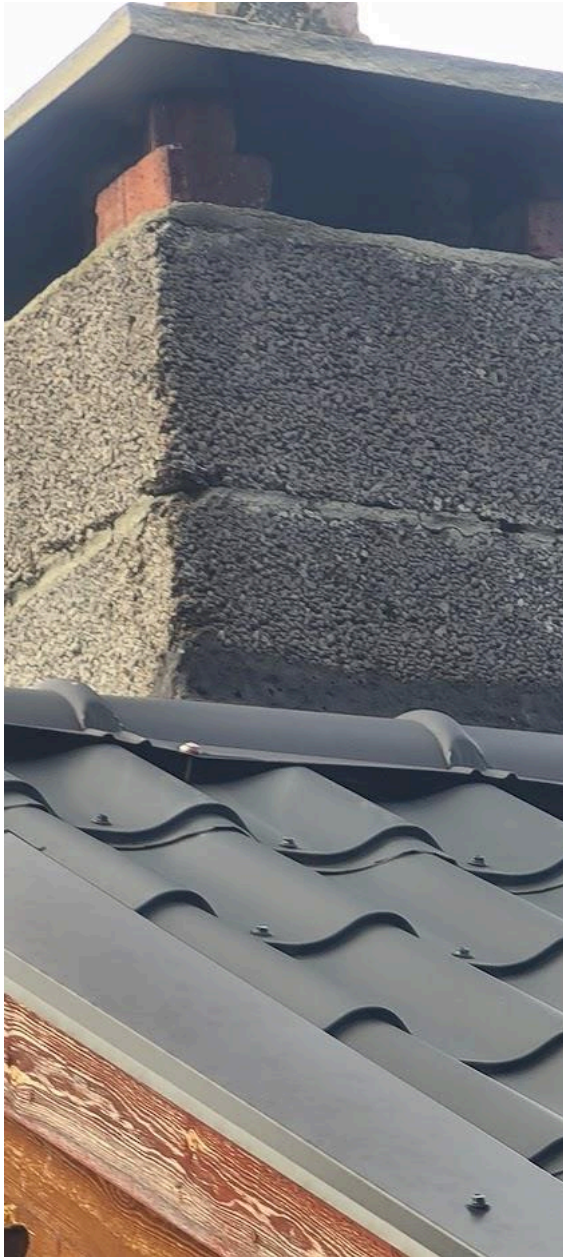
Elementpipe over tak.
