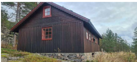
Tømmermannskledning med liggende kledning i topp gavl.
