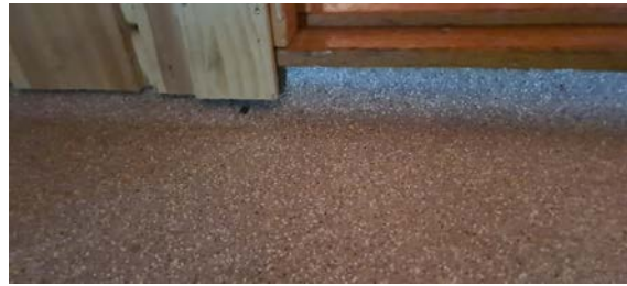
Terrazzo montert på sokkel under panel.
