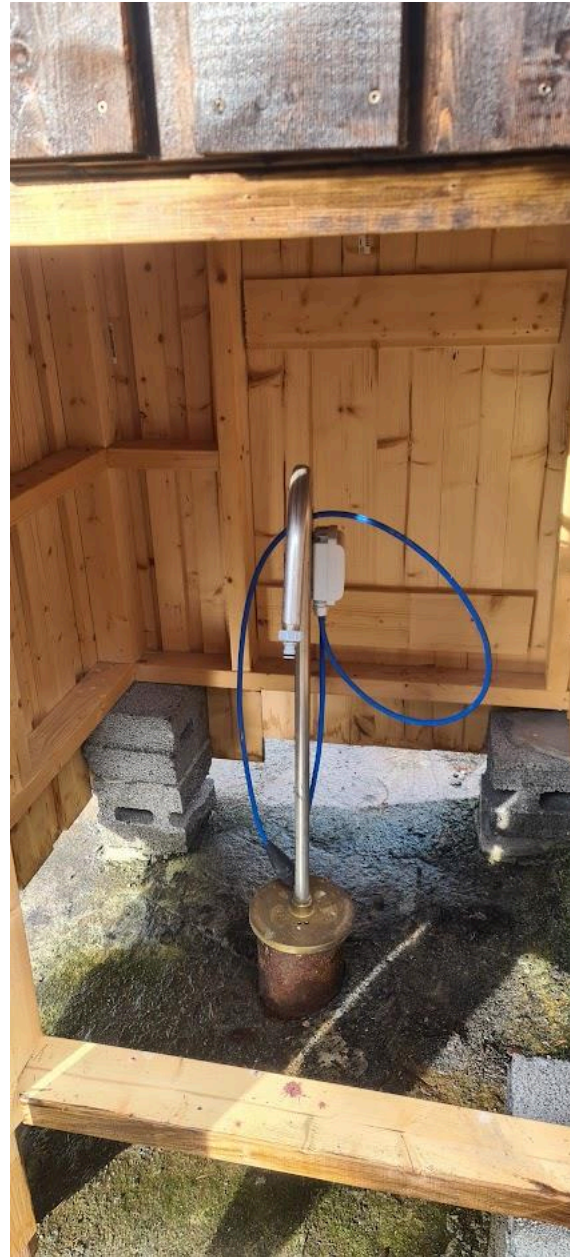
Innvendig i bygning over bergborebrønn.
