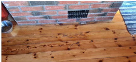
Gulv i passasje fra stue til kjøkken.
