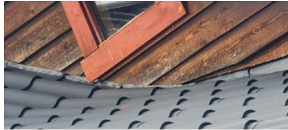
Overgang takplater/kledning på vegg.
