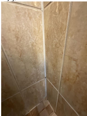
Sprekker flisfuger dusjhjørne
