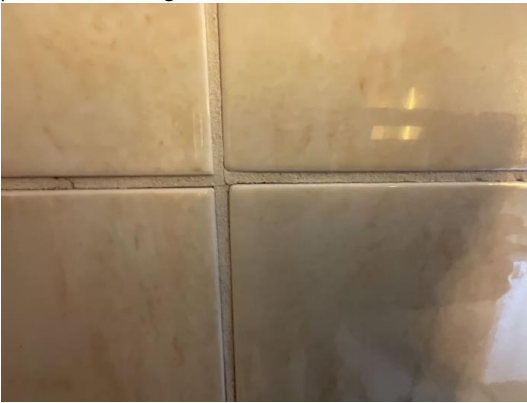
Sprekker flisfuger dusjhjørne
