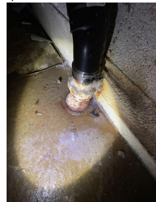
Nyere vanninntak m/varmekabel
