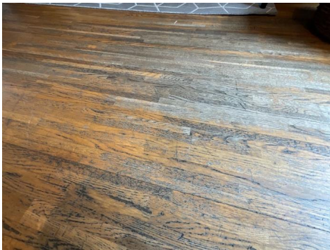
Ufagmessig laminatskjøter (ikke forskjøvet tilstrekkelig)
