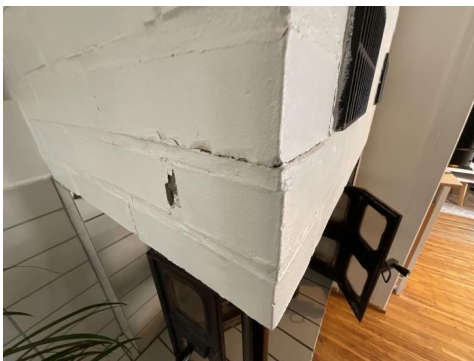
Sprekk flis, ikke ubrennbar plate på gulv
