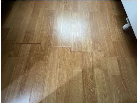
Ufagmessig laminatskjøter (ikke forskjøvet tilstrekkelig)
