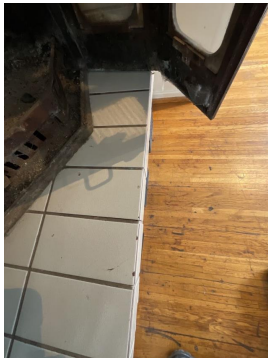
Sprekk flis, ikke ubrennbar plate på gulv
