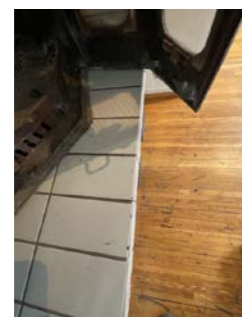
Sprekk flis, ikke ubrennbar plate på gulv
