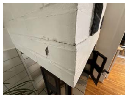
Sprekk flis, ikke ubrennbar plate på gulv
