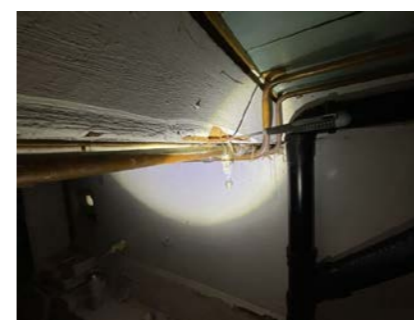
Litt råte i nedkant bjelke ved luke
