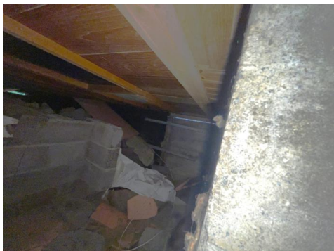
Bilde tatt inn fra lufterventil i tilbygg.
