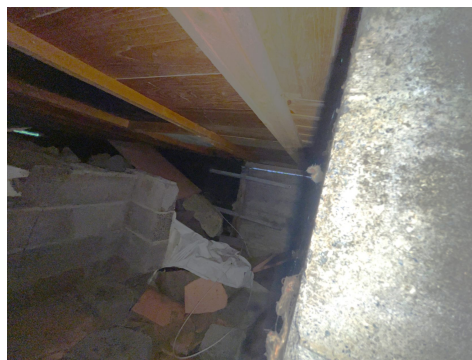
Bilde tatt inn fra lufteventil i tilbygg.
