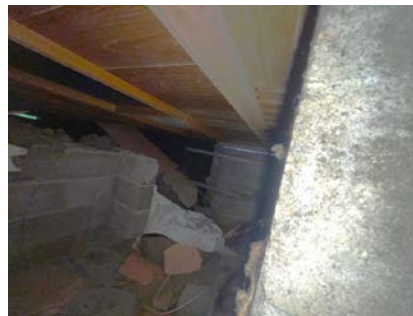
Bilde tatt inn fra lufterventil i tilbygg.
