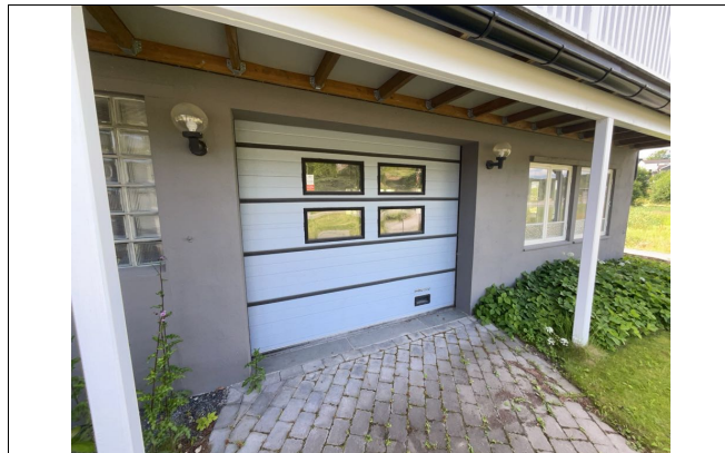
Port mot verksted, 2.67m brei og 2.28m høy.
