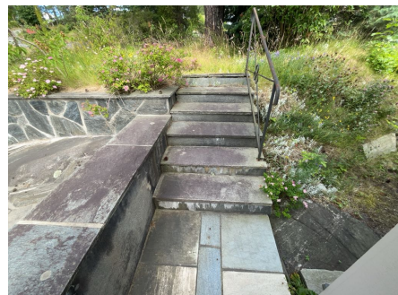
Utvendig trapp i tre med skiferheller i trinn.
