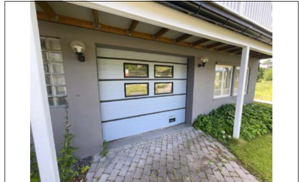
Port mot verksted, 2.67m brei og 2.28m høy.
