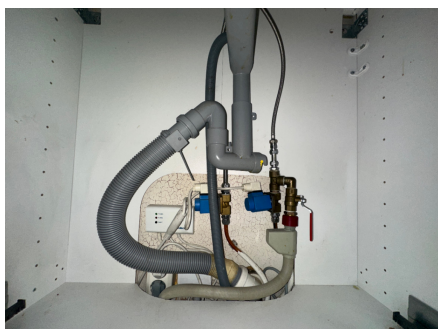
Rørapplegg i kjøkkenbenk med Waterguard
