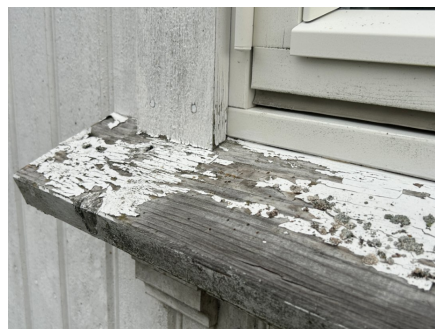
Vindusomramming står i kontakt med underbeslaget og mangler beslag.
