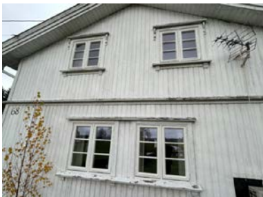
Utvendig listing av vinduer er ikke fagmessig utført.
