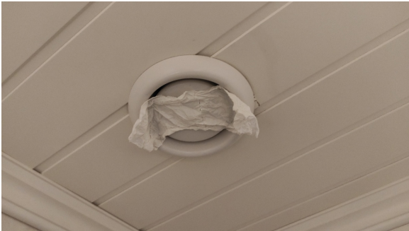
Funksjonstest av avtrekk.
