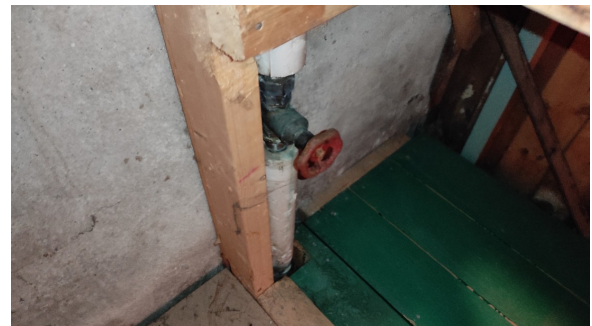
Hovedstoppekran kjelleretasje.
