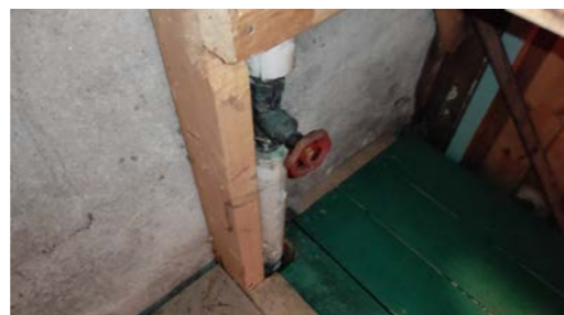
Hovedstoppekran kjelleretasje.
