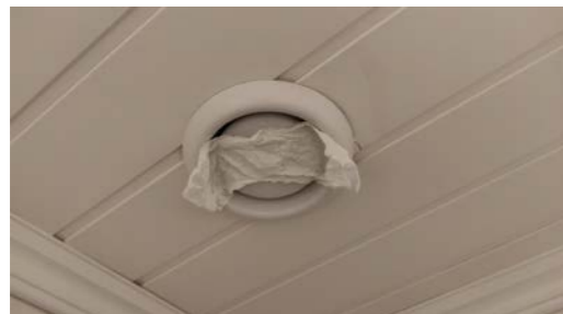
Funksjonstest av avtrekk.
