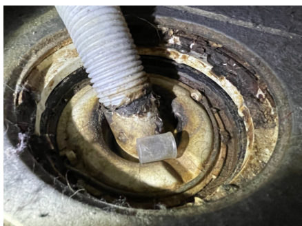
Ingen membran i sluk
