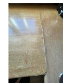
Slitasje i skjøt på benkeplate
