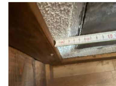
Sotluke for nærme brennbart, og ingen ubrennbar plate på gulv under sotluke
