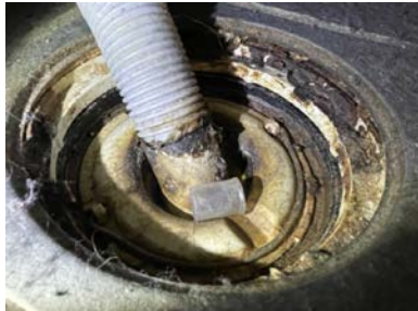
Ingen membran i sluk
