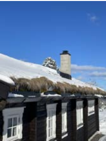
Merker etter fukt og fukt i trevirke i takrenner
