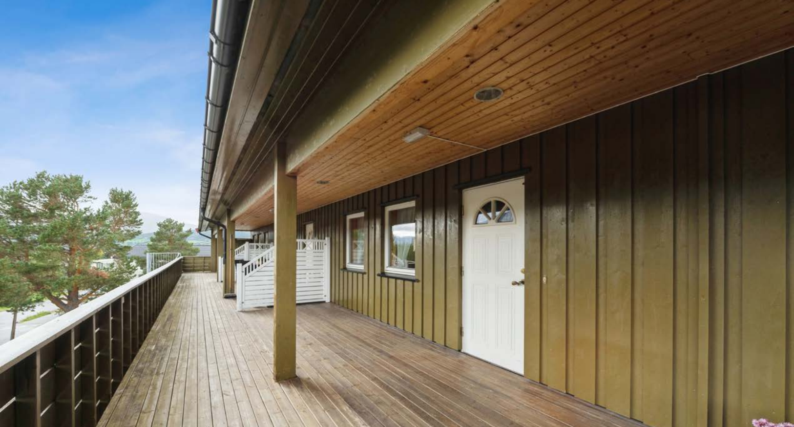
Svalgang med romslig veranda
