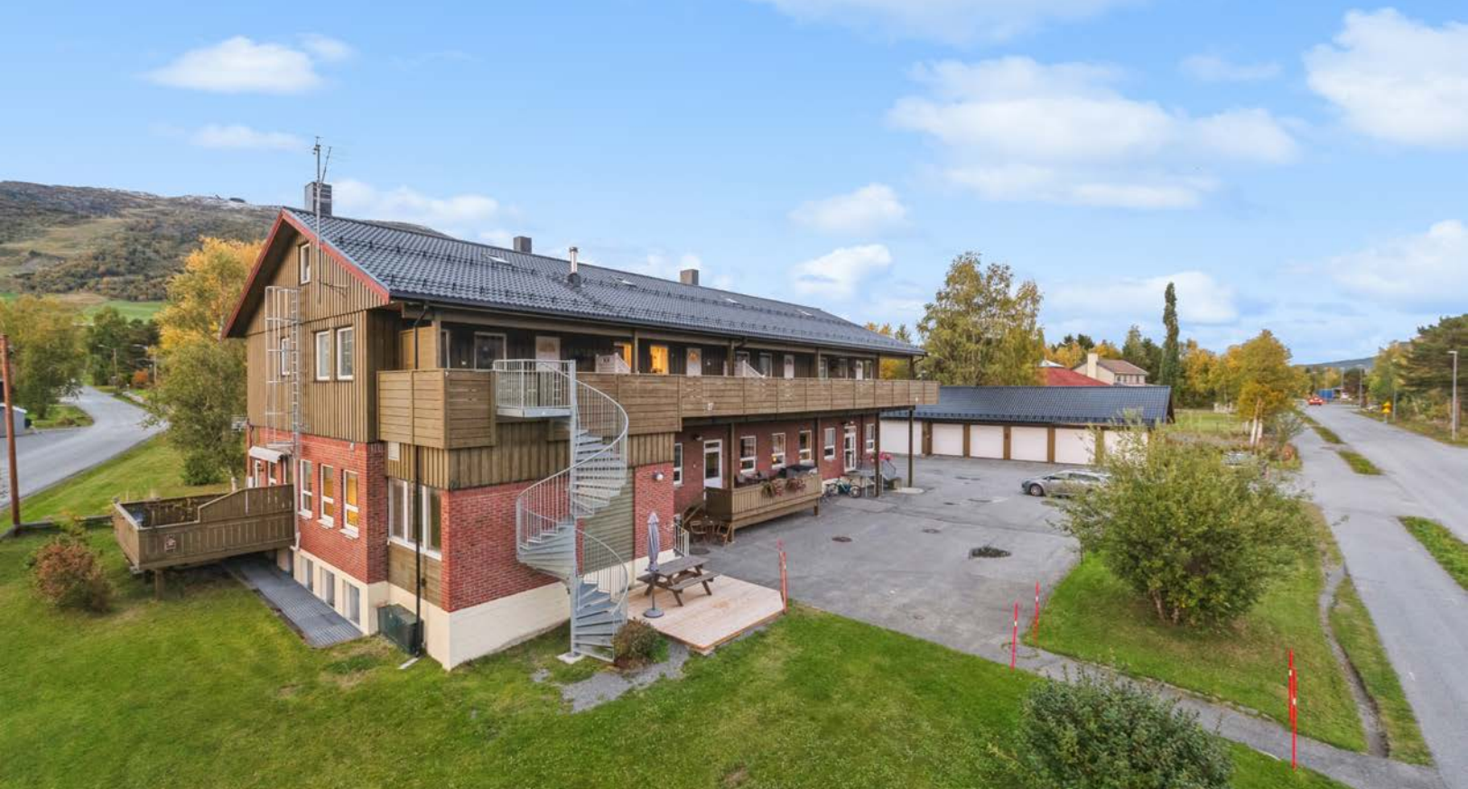
Sameiets tomt er delvis inngjerdet og opparbeidet med plen, beplantning og asfaltert gårdsplass
