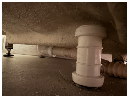
Avløpsrør fra tidligere badekar under dusj-kabinett
