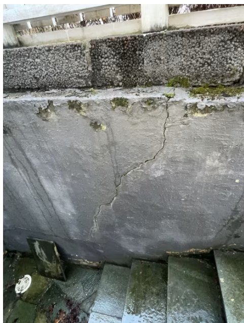
Forstøtningsmur til trapp.
