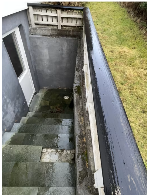
Trapp i betong til kjeller hall/gang.
