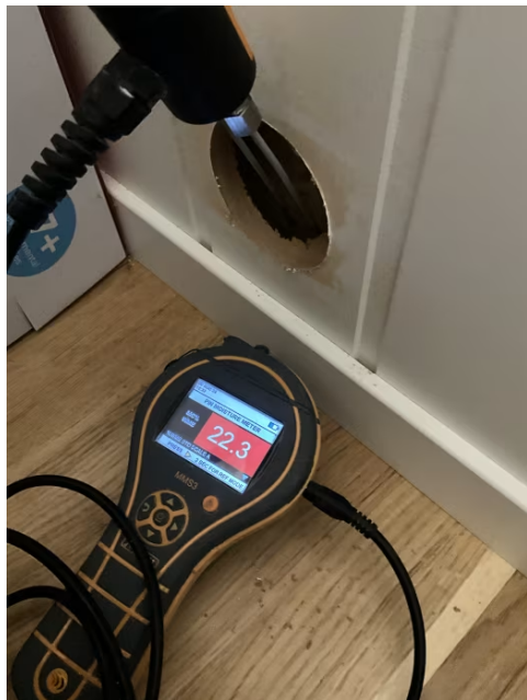
Hulltaking med fuktmåling fra soverom mot vest.
