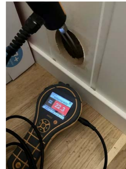
Hulltaking med fuktmåling fra soverom mot vest.
