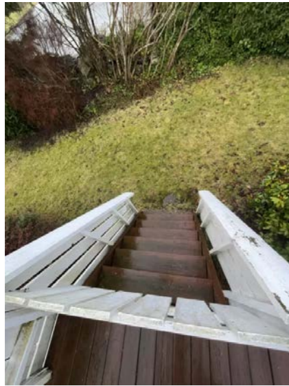
Terrasse trapp i tre.
