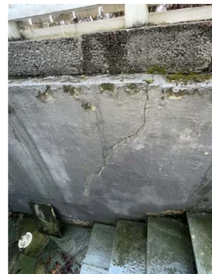
Forstøtningsmur til trapp.
