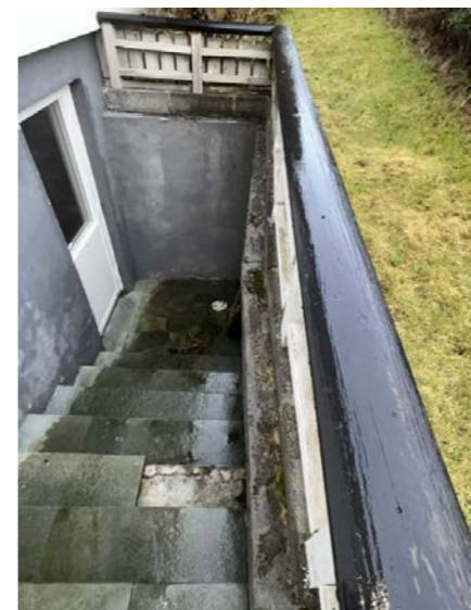
Trapp i betong til kjeller hall/gang.
