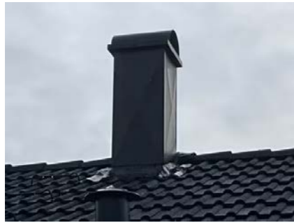
Utvendig pipe med pipebeslag og bly i overgang til takstein.
