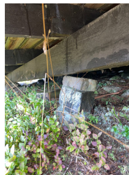
Det er registrert stedvis skader i bjelker/svikt i gulv
