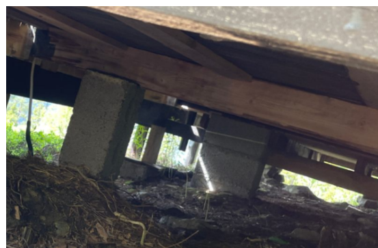
Stikkrør har falt av nedløpsrør.
