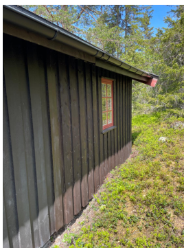
Terreng faller mot vegg/hytte på østside
