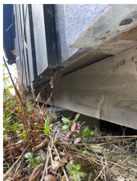
Stedvis noe løse kledningsbord.
