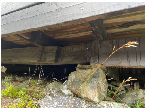
Ufaglig skjøting av bærende konstruksjoner.
