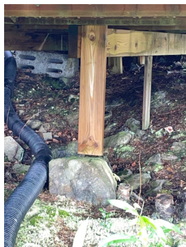
Ufaglig skjøting av bærende konstruksjoner.
