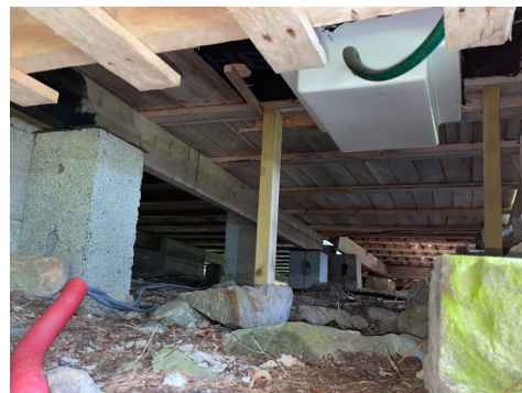
Noe provisorisk understøttelse.
