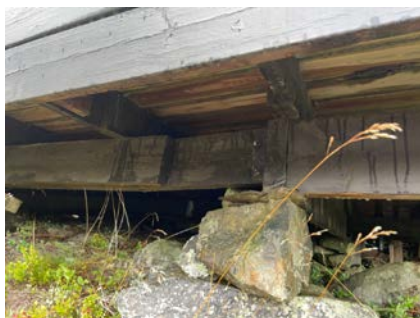
Ufaglig skjøting av bærende konstruksjoner.
