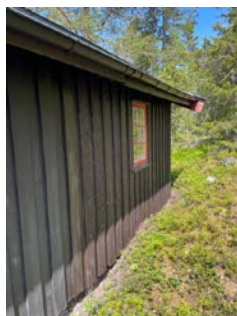
Terreng faller mot vegg/hytte på østside
