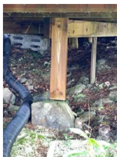
Ufaglig skjøting av bærende konstruksjoner.
