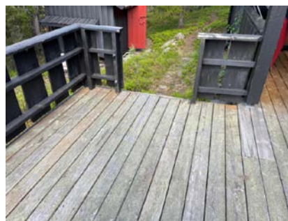
Det er registrert stedvis skader i bjelker/svikt i gulv
