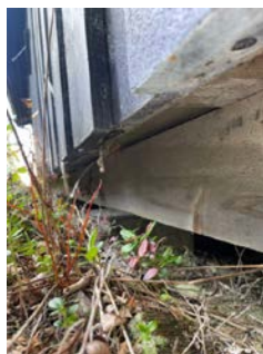
Stedvis noe løse kledningsbord.
