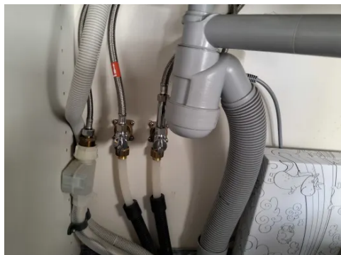
Boligen har synlige avløpsrør av plast.
