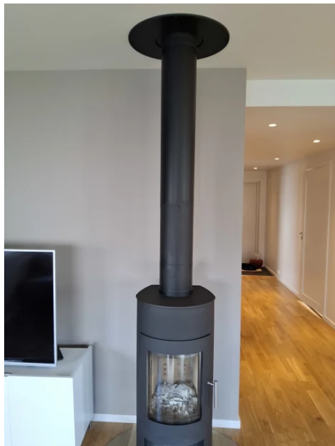
Vedovn med glassdør i stue tilknyttet stålpipe.
