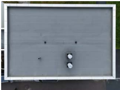
Taktekking av PVC-basert takmembran.
