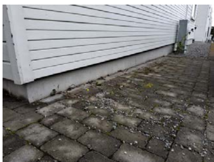
Boligen er oppført med støpt plate på mark.
