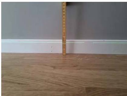
Etasjeskillet er kontrollert med nivelleringslaser.
