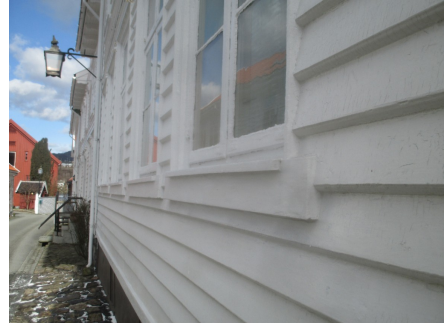
Deler av fasade i mot gate.
