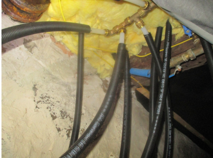
Rør i rør med åpne koblinger i grovkjeller
