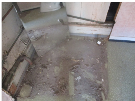
Må bygges opp på nytt.
