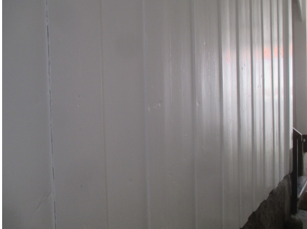
Kledning i portrom.
