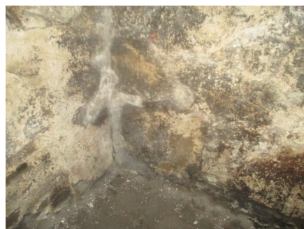
Deler av tykk grunnmur.
