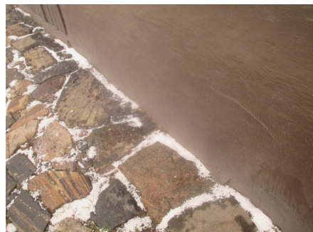
Deler av pusset grunnmur
