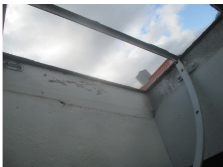
Eldre takvindu på kaldtloftet.
