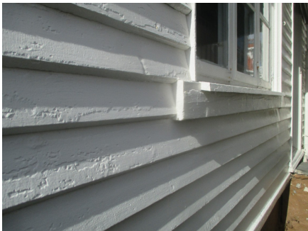
Deler av opprinnelig kledning med tilhørende belistninger.
