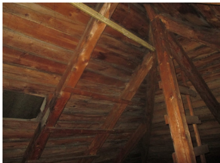
En del misfarging på undertak av bord
