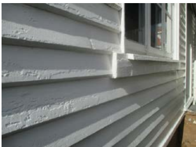
Deler av opprinnelig kledning med tilhørende belistninger.
