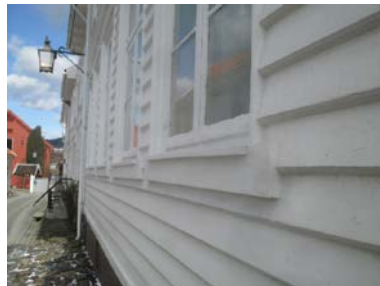
Deler av fasade i mot gate.
