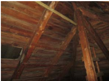
En del misfarging på undertak av bord
