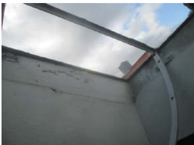
Eldre takvindu på kaldtloftet.
