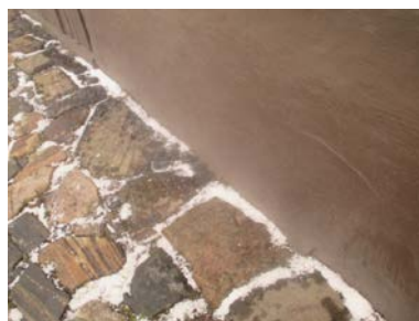
Deler av pusset grunnmur
