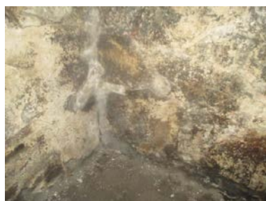
Deler av tykk grunnmur.
