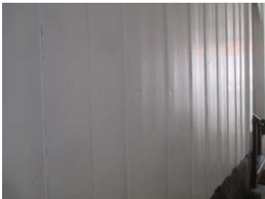
Kledning i portrom.
