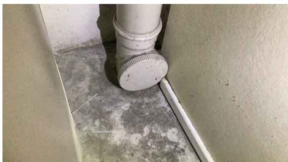
Stakepunkt i kjeller.
