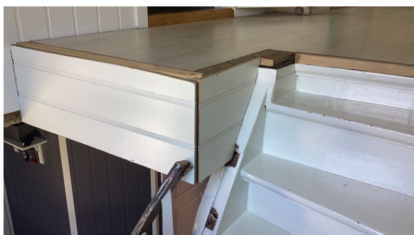
Trapp til 2. etasje.
