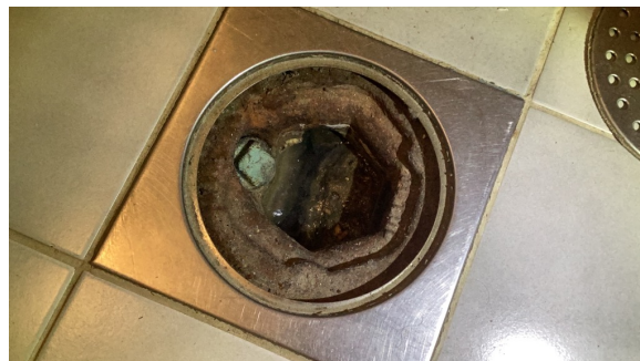
Sluk av jern. Ikke tegn til membran.
