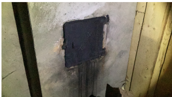
Sotluke i kjeller.
