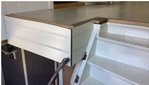
Trapp til 2. etasje.
