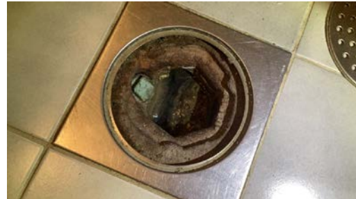
Sluk av jern. Ikke tegn til membran.
