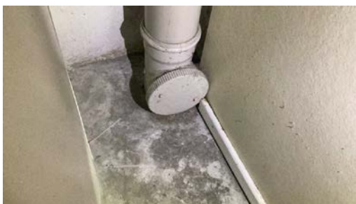
Stakepunkt i kjeller.
