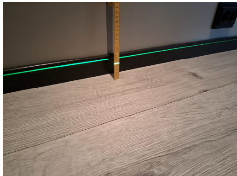
Etasjeskille er kontrollert med nivelleringslaser.
