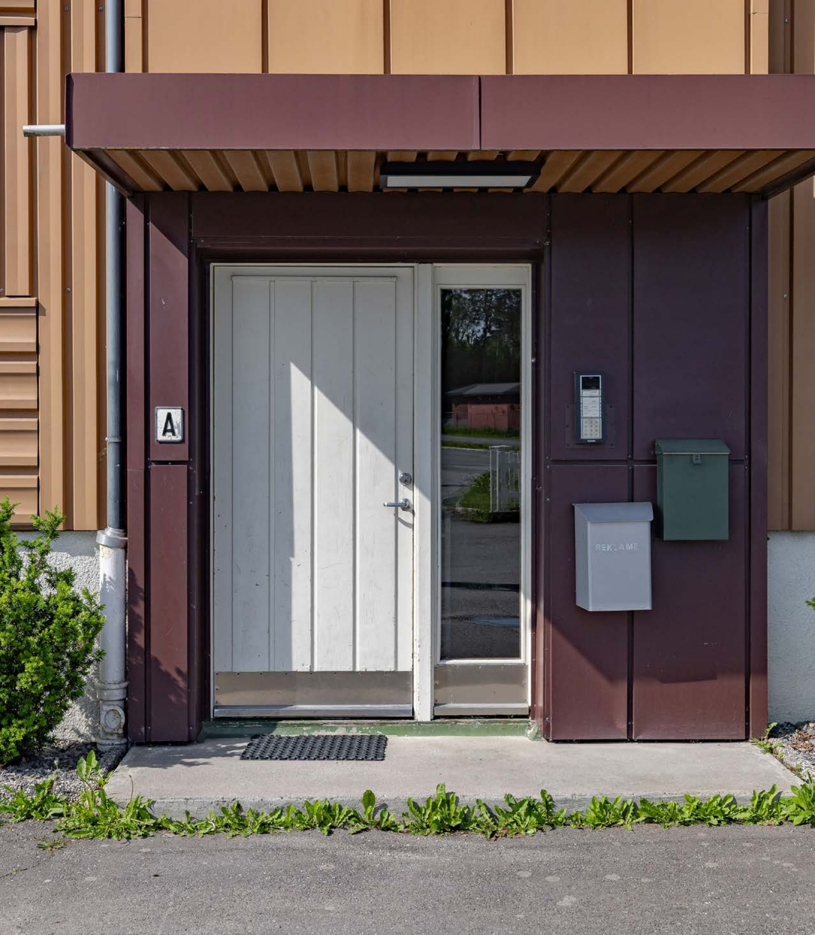
Overbygget inngangsparti med callinganlegg.
