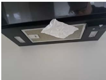
Kjøkkenventilator er testet med papir.
