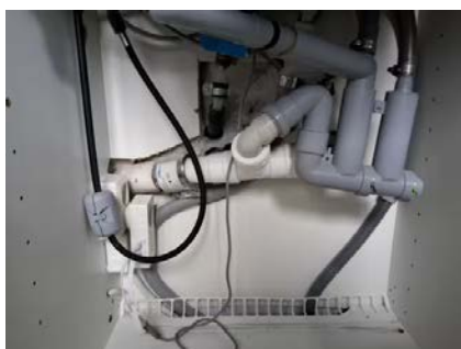
Synlige avløpsrør av plast og støpejern.
