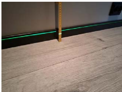
Etasjeskille er kontrollert med nivelleringslaser.
