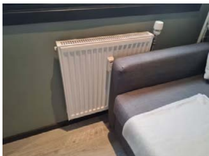
Radiator på ett soverom er skiftet.
