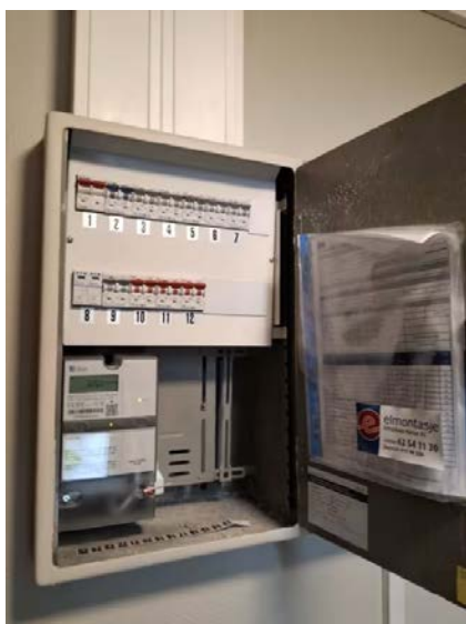
Sikringsskap er plassert i felles trappeoppgang.
