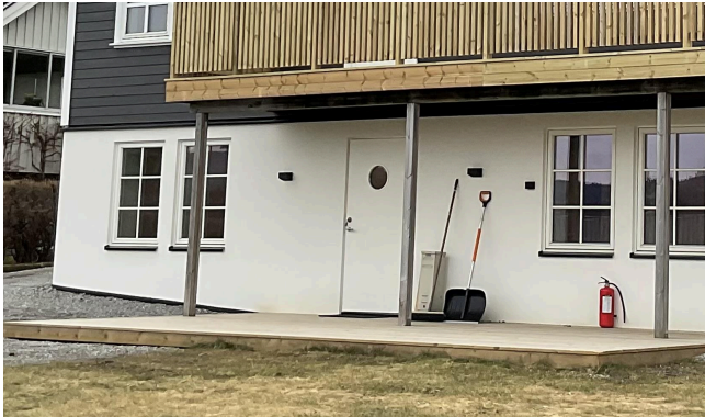
Treplattning ved inngang u.etasje
