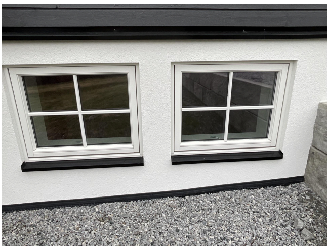
Synlig fuktsikring rundt bolig
