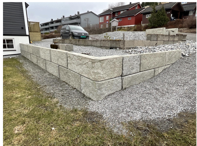
Bilde av forstøtningsmur
