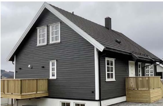
Malt liggende kledning
