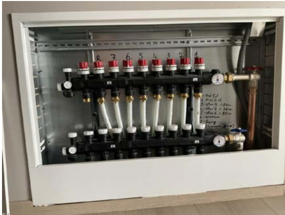
Styring for vannbåren varme i u.etg
