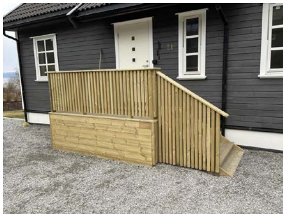
Ny trapp/terrasse ved hovedinngang
