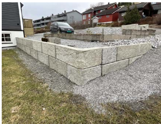
Bilde av forstøttningsmur
