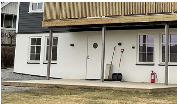
Treplattning ved inngang u.etasje
