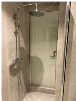
Dør fra kjeller plassert i dusjsone
