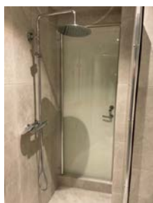
Dør fra kjeller plassert i dusjsone
