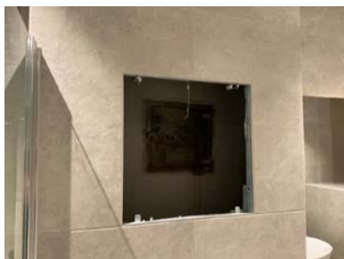
Feieluke inne i innkassing for klosett
