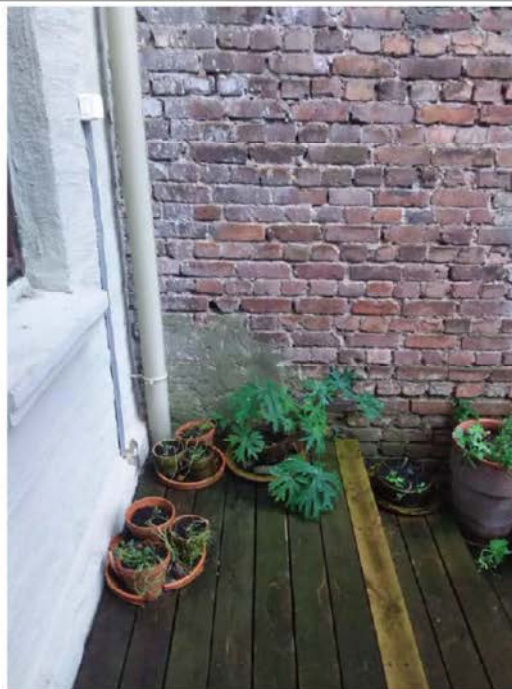
nabobakgården - platting og takrenne.
