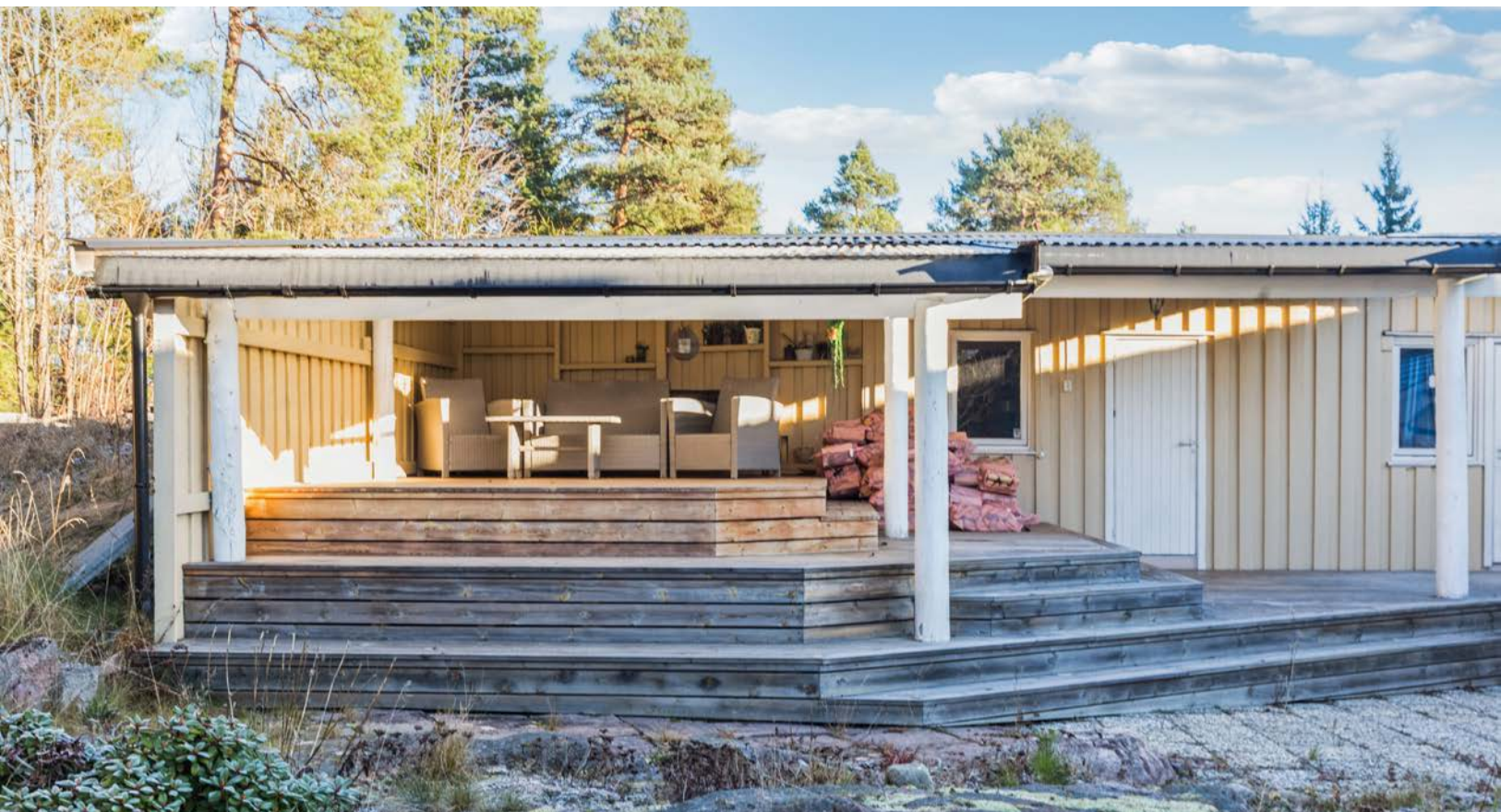
Fin overbygget uteplass i tilknytning til annekset og bod.
