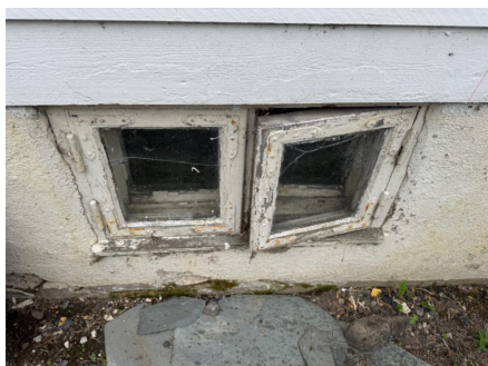
Sprekt glass i kjellervinduer
