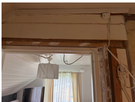
Løse ledninger og kontakter
