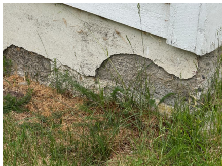
Avflassing på grunnmur
