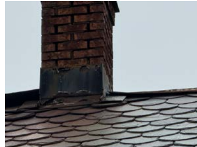
Slitt beslag på pipe
