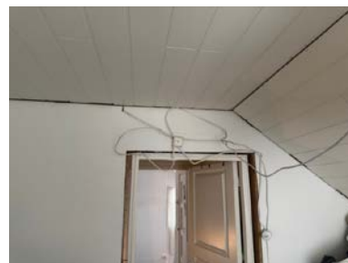
Løse ledninger og el. punkter
