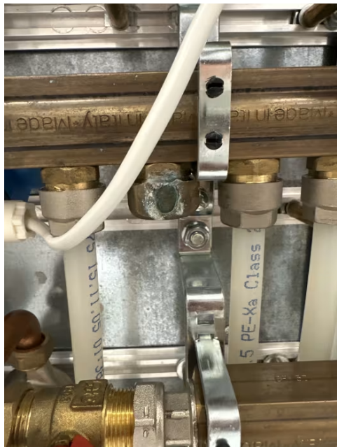
Viser irr og drypplekkasje på kobling.
