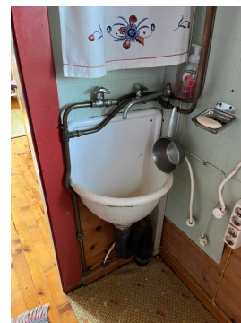
Vannrør av kobber til utslagsvask.
