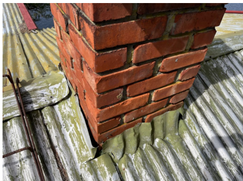
Manglende tett beslag rundt pipe.
