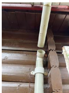
Manglende tett beslag rundt pipe.
