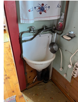
Vannrør av kobber til utslagsvask.
