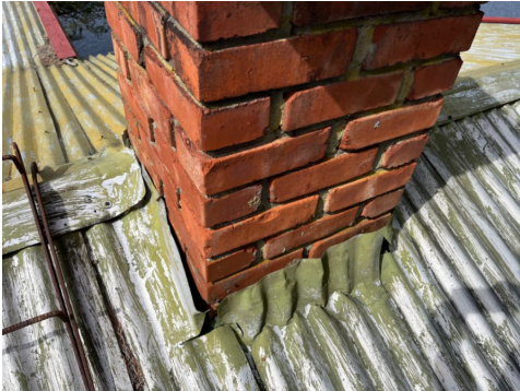
Manglende tett beslag rundt pipe.
