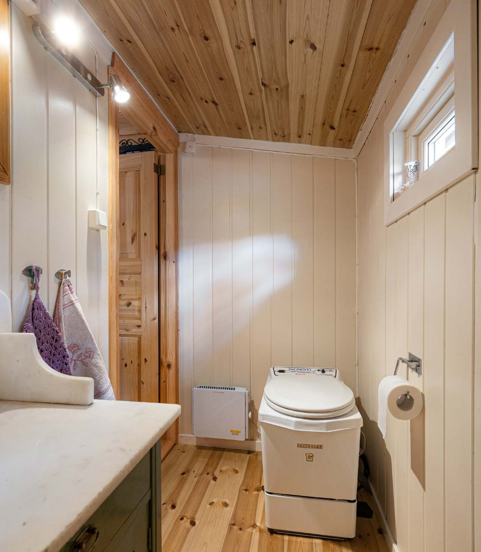
På tolaetrommet er det et Incinolet forbrenningstolett.
