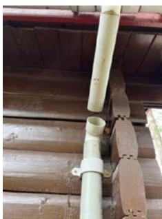
Manglende tett beslag rundt pipe.
