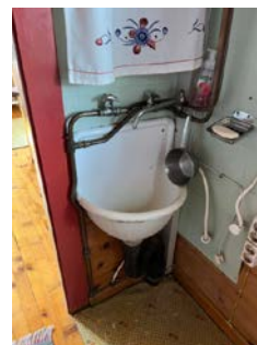
Vannrør av kobber til utslagsvask.
