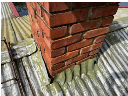
Manglende tett beslag rundt pipe.
