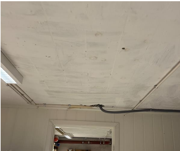
Figur 35: Betongdekke i kjeller, fra byggeår.
