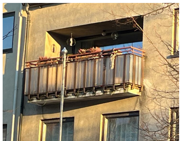
Figur 92: Balkong mot Kongens gate.
