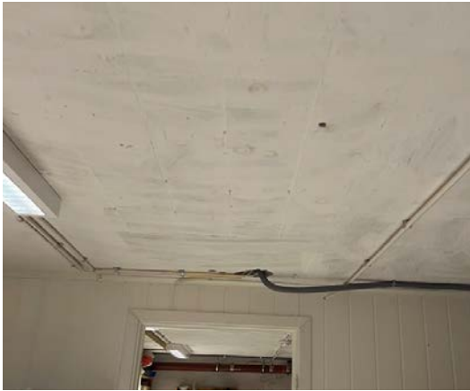
Figur 35: Betongdekke i kjeller, fra byggeår.
