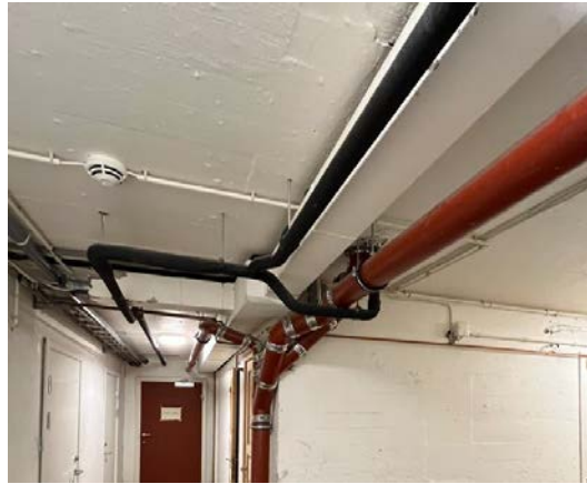
Figur 46: Betongdekke i kjeller.
