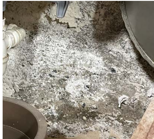
Figur 4: Kjellervegg med saltutslag..
