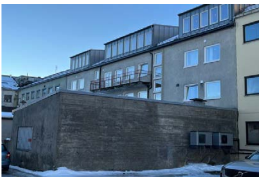
Figur 2: Fasade mot Skolegata.
