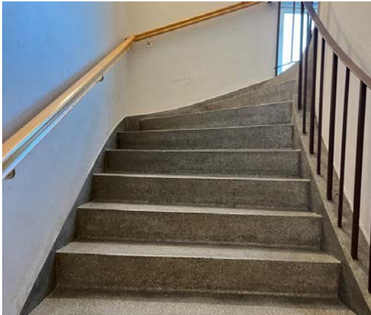
Figur 19: Hovedtrapp innvendig, generell tilstand.
