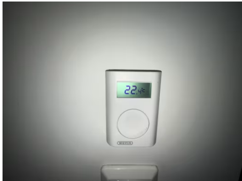
Regulering av gulvvarme via trådløse termostater.
