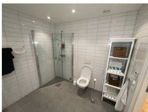
Innfrellbare dusjvegger, veggmontert termostattbatteri og dusjgarnityr. Veggmontert toalett med innebygget systerne.
