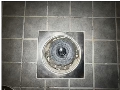
Viser sluk i dusjsonen.
