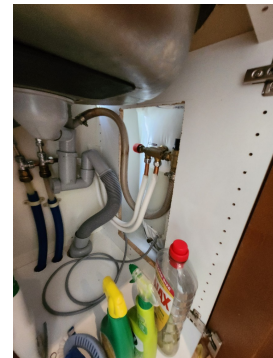
Varmtvannsbereder i kjøkkenbenk. Rør i rør vann ledninger.
