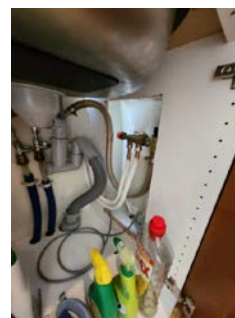
Varmtvannsbereider i kjøkkenbenk. Rør i rør vann ledninger.
