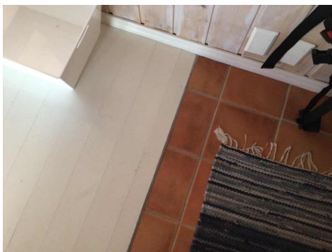
Del av innvendig gulv.
