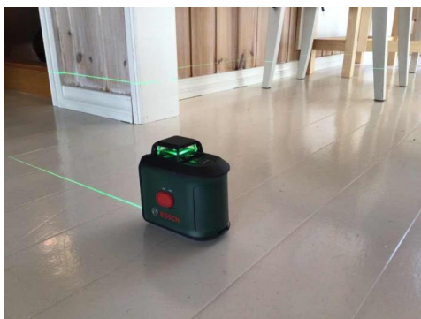
Målt avvik på etasjeskille.
