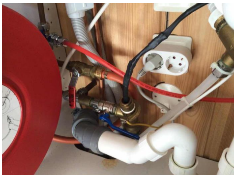
Stoppekran i kjøkkenbenk.
