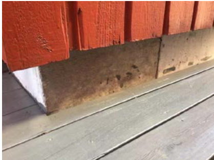
Del av støpt plate på mark.
