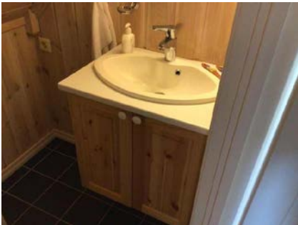
Montert innredning med vask.
