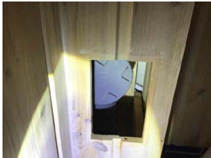
Hull i vegg som ble brukt for kontroll av fukt.
